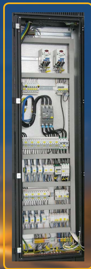
System sterowania stanowiskiem badawczym: z lewej strony sterownik PLC z osprzętem, z prawej strony podzespoły mocy
