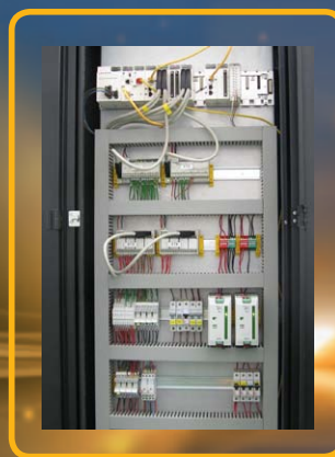
System sterowania stanowiskiem badawczym: z lewej strony sterownik PLC z osprzętem, z prawej strony podzespoły mocy
